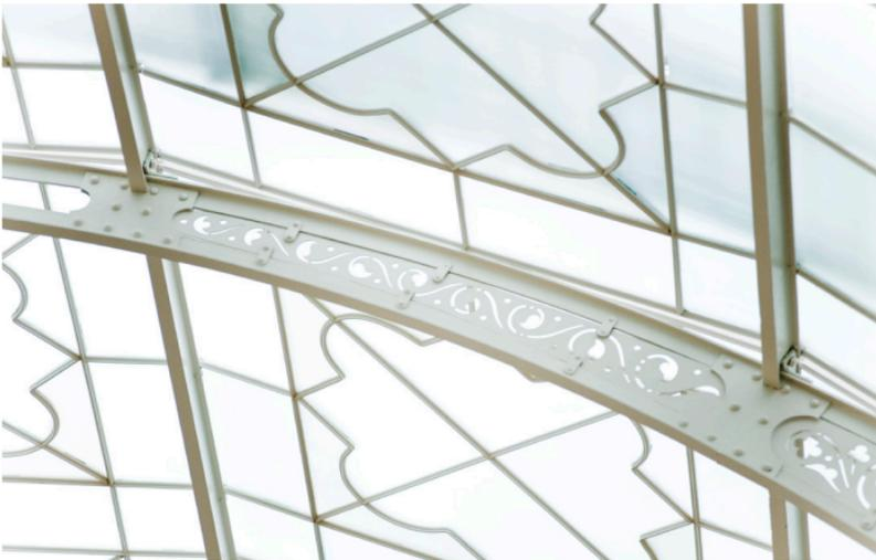
Aus Sicherheitsgründen (eine Glasscherbe, die aus 18 Metern Höhe fällt, kann eine tödliche Waffe sein!) wurden die Glasscheiben während der Restaurierung verdoppelt. Zunächst wurde eine Replik von jeder Scheibe angefertigt. Original und Replik wurden anschließend durch eine Harzschicht miteinander verbunden, um so eine Doppelverglasung zu erhalten.
