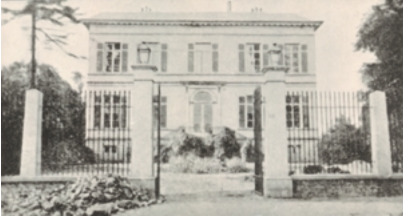
Het kasteel-Puissant in Charleroi, waar ooit het agentschap was gevestigd
