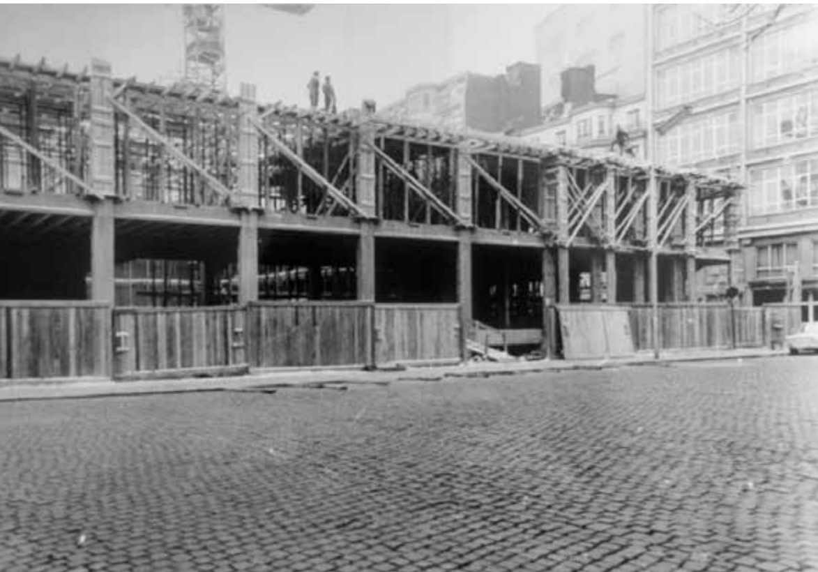
La structure de la façade en cours de construction
